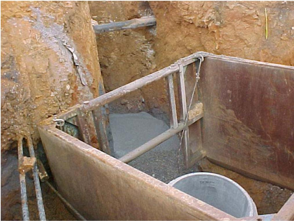
**Figure 6-7. In-Trench Barrier (Saenz 2002)**
